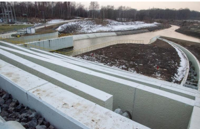
Ukończona przepławka przy nowej zaprzecie zbiornika Niedów, fot. Jacek Staszczuk
